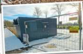
„Die Eingänge zum Platz haben wir demnach noch zugesperrt, damit jetzt hier nicht jeder die Baustelle betritt oder gar befährt.“ Ursprünglich hatten sich die Verantwortlichen vor-
